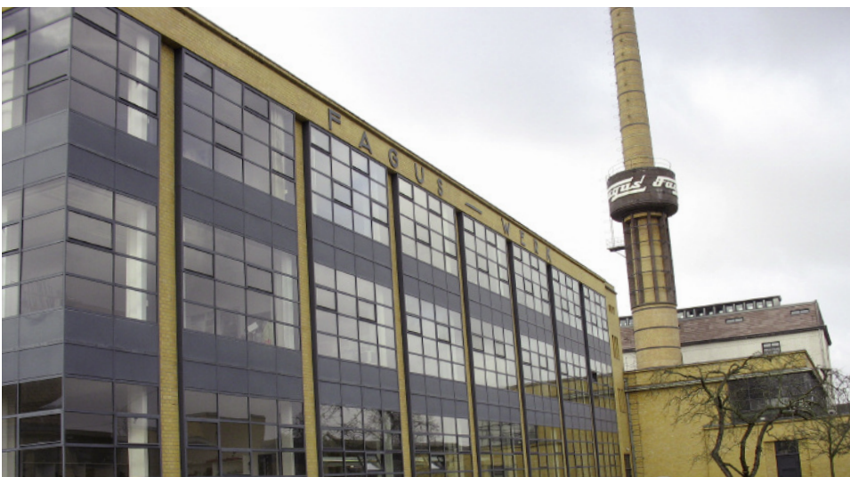
Blick auf die Glasfassade des Weltkulturerbes
